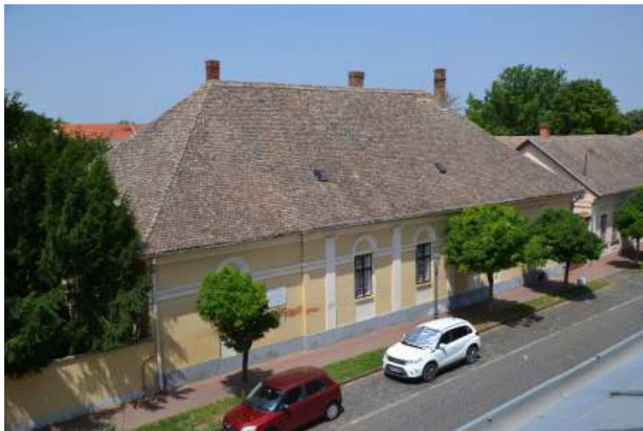
Az 1836-ban épült parókia tetőszerkezete felújítást igényelt
